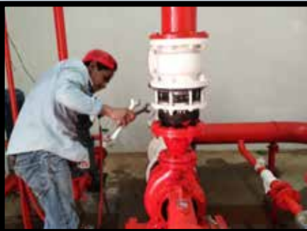
Kerja-kerja penyelenggaraan dan pembaikan sistem pencegahan kebakaran.
