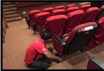
Kerja-kerja menanggal karpet lama yang rosak serta membekal dan memasang permaidani baharu di keseluruhan auditorium.
