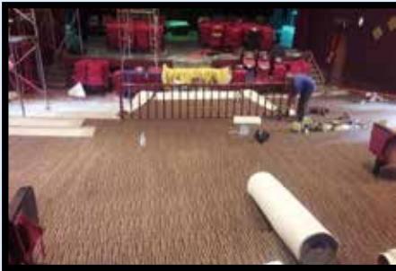
Kerja-kerja menanggal karpet lama yang rosak serta membekal dan memasang permaidani baharu di keseluruhan auditorium.
